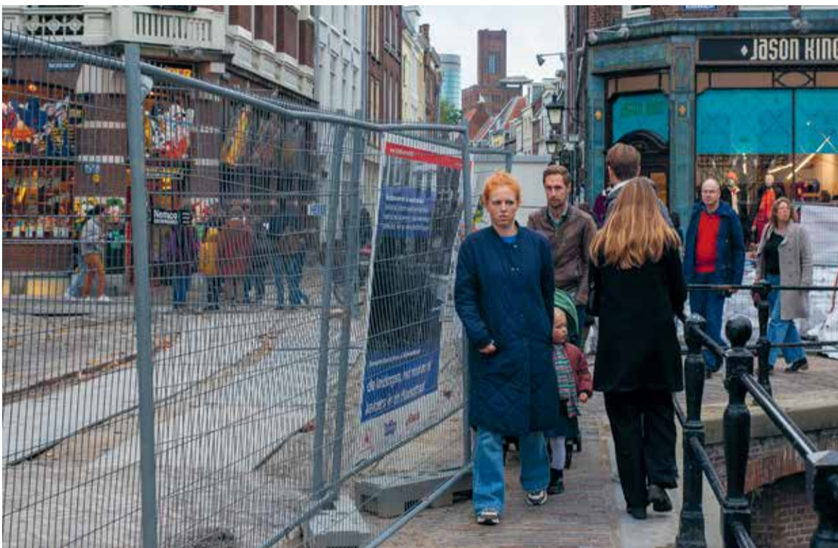
De brug bij de Haverstraat/hoek Oudegracht is al maanden lang terrein van werkzaamheden. Foto: Gert-Jan Peddemors
